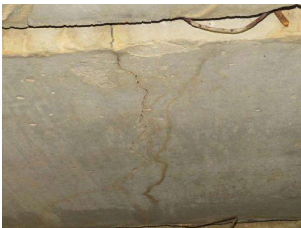
Рисунок 3 – Поперечні тріщини секції водопропускної труби Figure 3 – Transverse cracks in the culvert section
